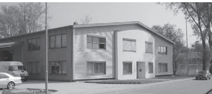
1997 Nouvelle construction du siège social à Eppingen
